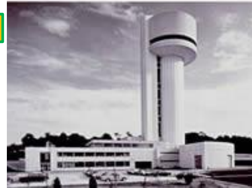
Un des plus haut tandem était a Daresbury, UK, 42 m de long, 20 MV
