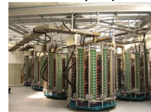
700 modules de 300W à 352MHz → total: ~190kW
